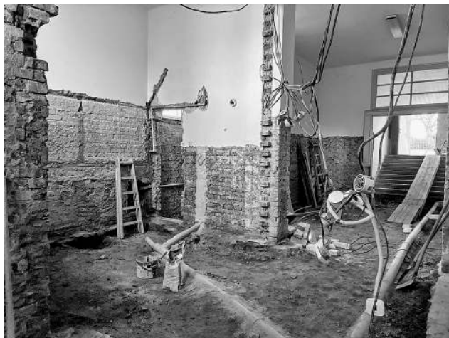
aktuální stav prací
