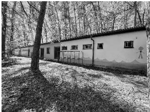
budova před rekonstrukcí
