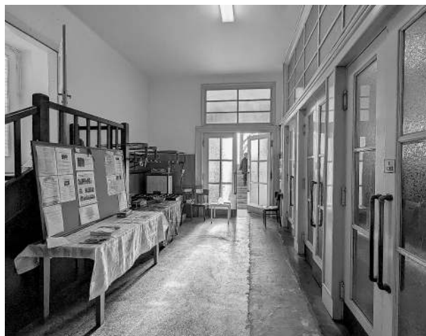
interiér sborového domu před rekonstrukcí
