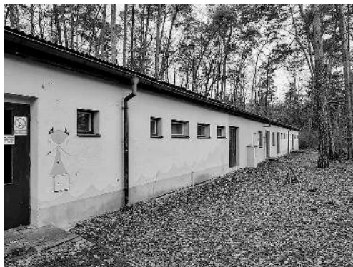
současný stav sanitárního zařízení
