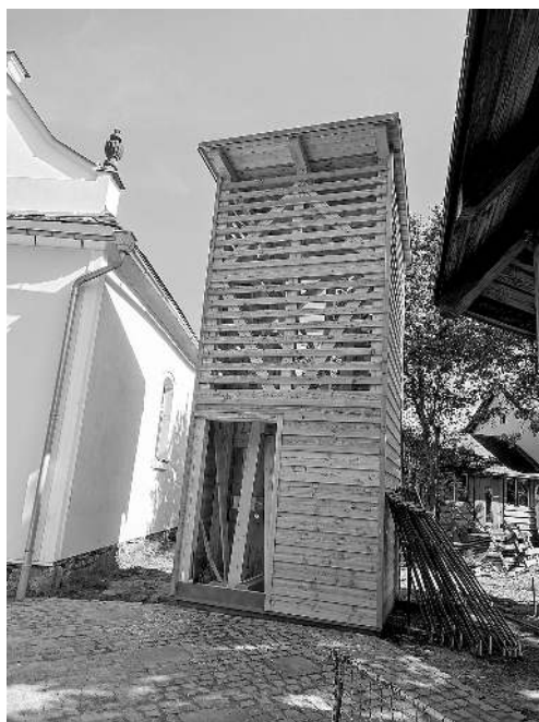
stavba zvonice v Libštátě
