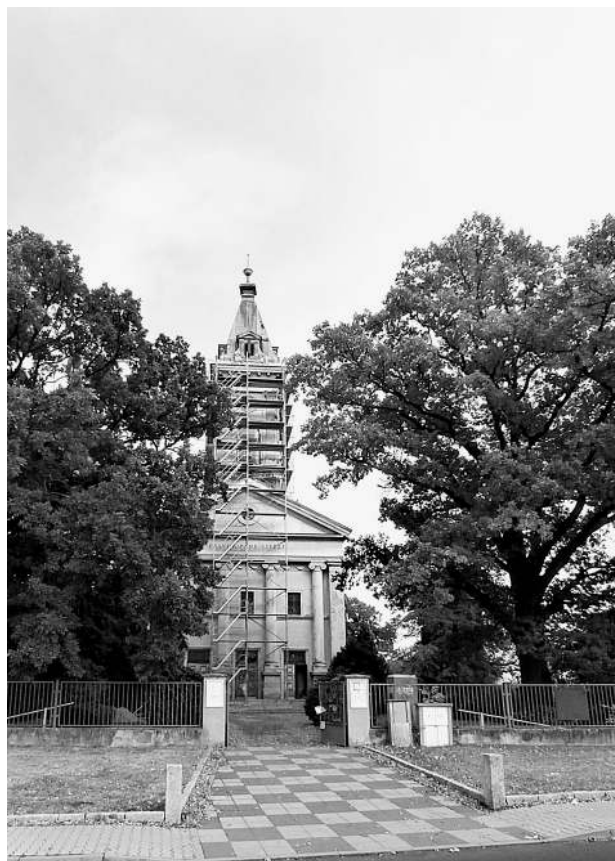
oprava věže kostela
