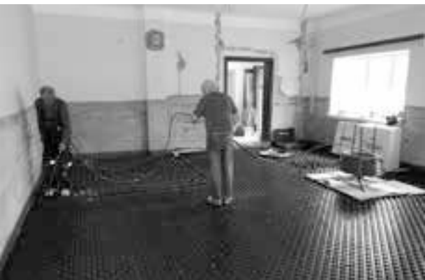
pokládání podlahového topení
