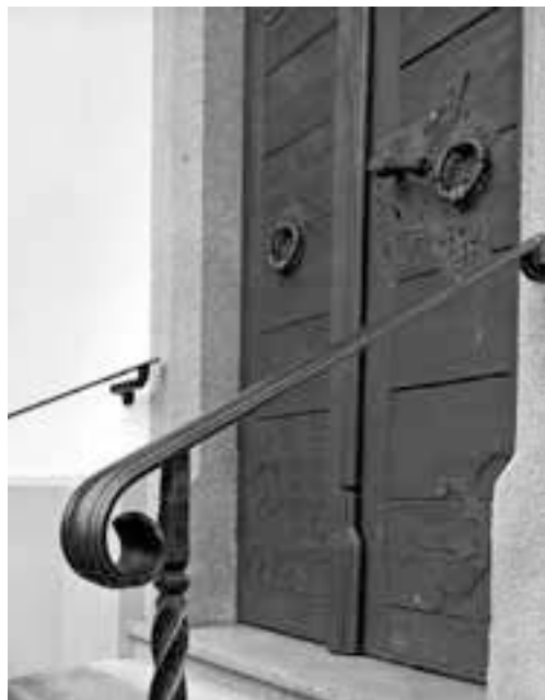
zábradlí u východu z kostela v Moravči
