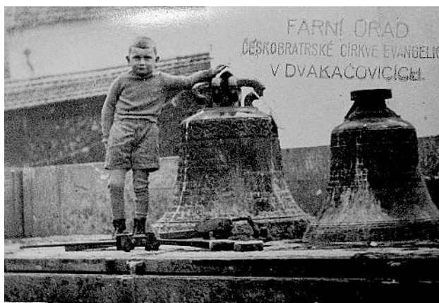
již sejmuté zvony, které byly zabaveny sboru v Dvakačovicích
